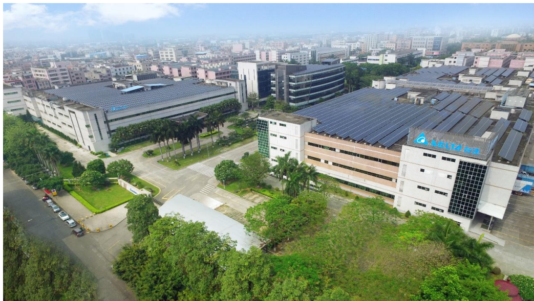
台达东莞厂区屋顶光伏
